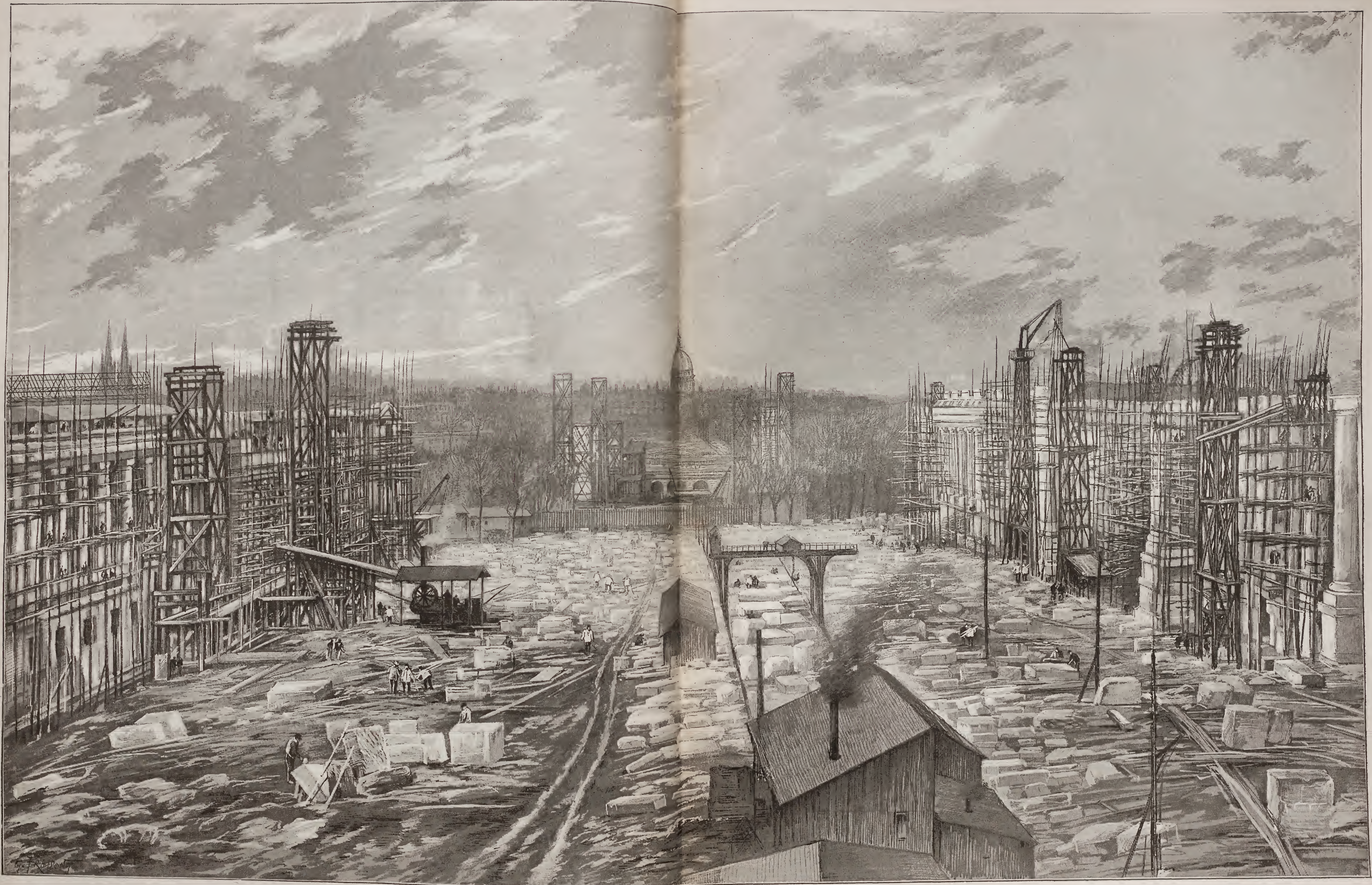
VUE GÉNÉRALE DES CHANTIERS DES PALAIS, DU PONT ALEXANDRE III ET DE L'ESPLANADE DES INVALIDES (Décembre 1868.)
